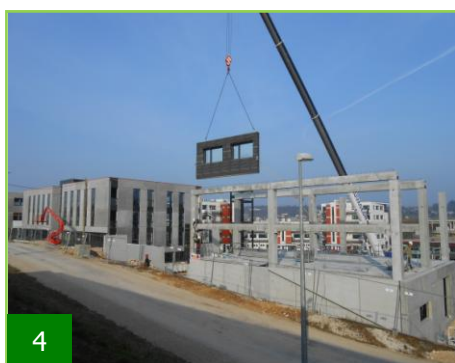
Montage des panneaux
