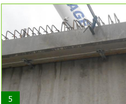
Fixation des panneaux à la structure porteuse
