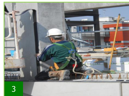
Pose des joints d'étanchéité
